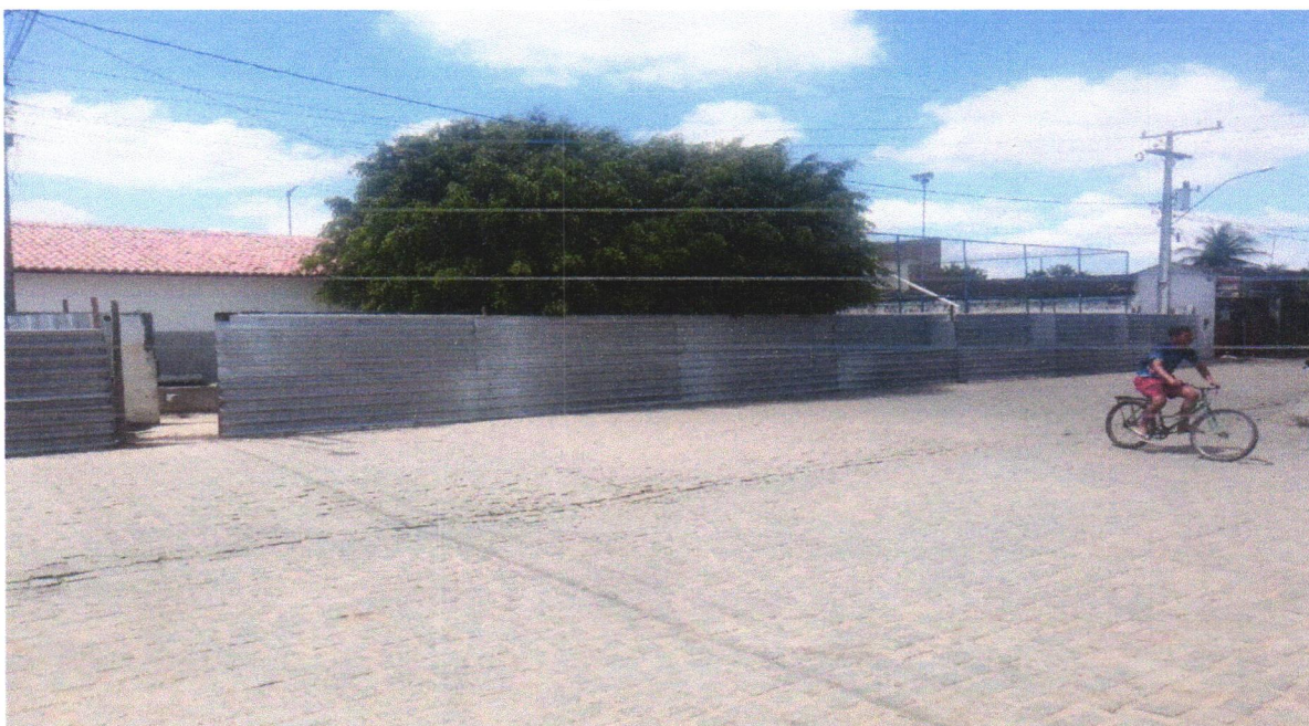
FOTO 02 - TAPUME COM TELHA METÁLICA. AF_05/2018
