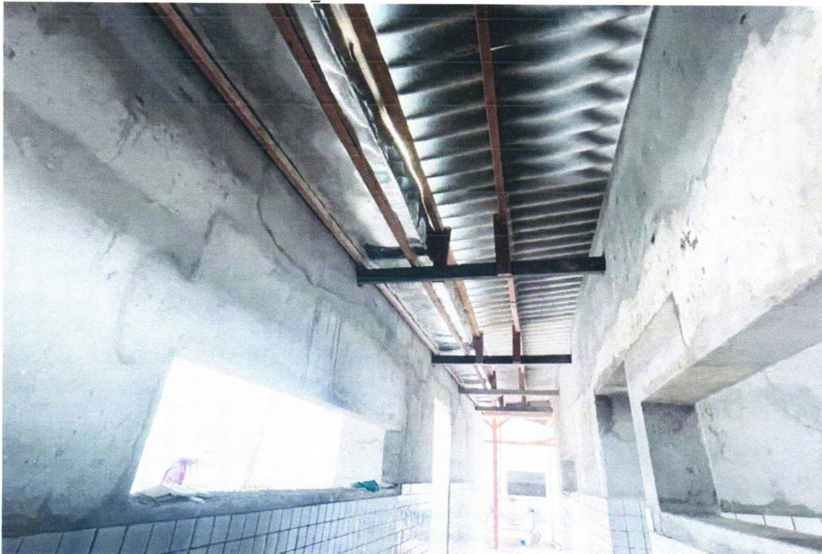
FOTO 26 - CALHA EM CHAPA DE AÇO GALVANIZADO NÚMERO 24, DESENVOLVIMENTO DE 50 CM, INCLUSO TRANSPORTE VERTICAL. AF_07/2019
