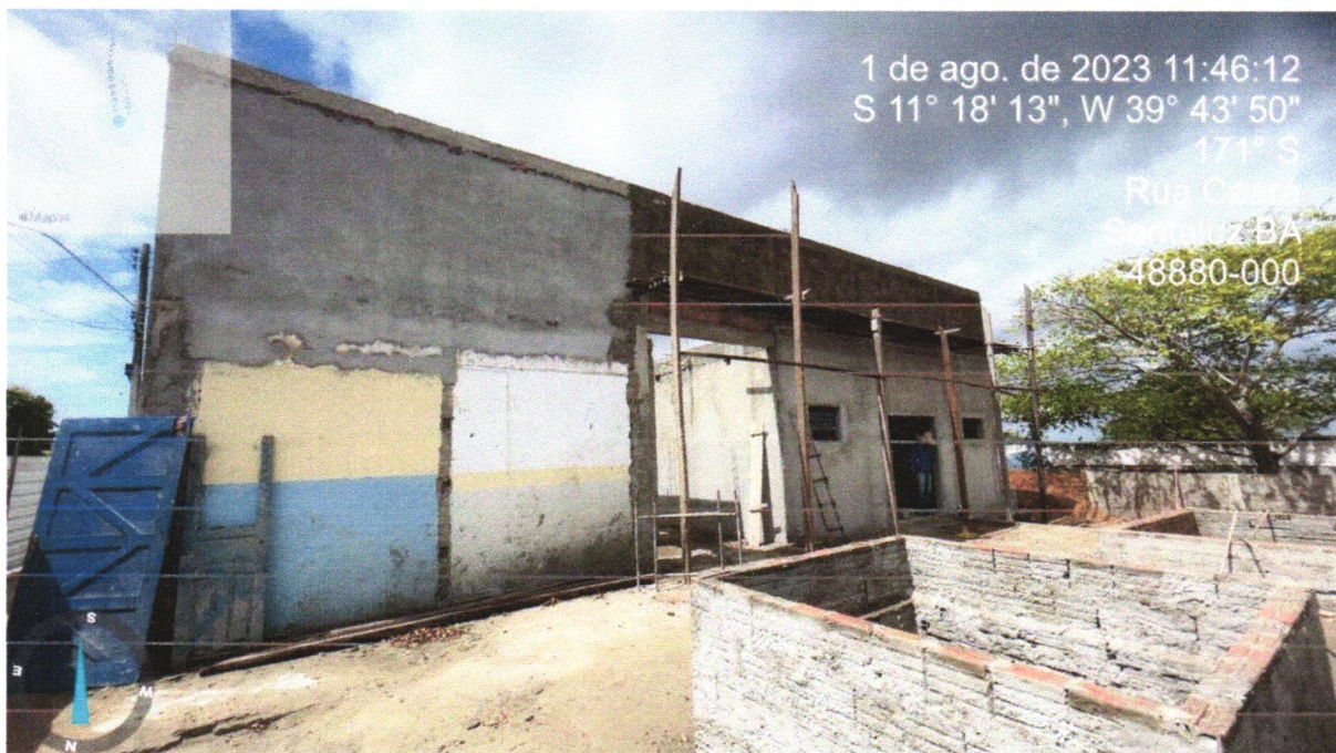
FOTO 04 - ALVENARIA DE VEDAÇÃO DE BLOCOS CERÂMICOS FURADOS NA HORIZONTAL DE 9X19X19CM (ESPESSURA 9CM) DE PAREDES COM ÁREA LÍQUIDA MAIOR OU IGUAL A 6M² SEM VÃOS E ARGAMASSA DE ASSENTAMENTO COM PREPARO EM BETONEIRA. AF_06/2014
