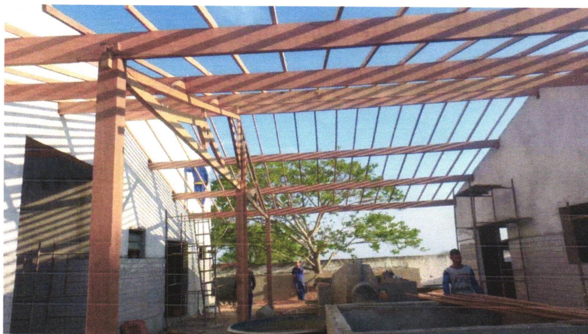
FOTO 24 - TRAMA DE MADEIRA COMPOSTA POR RIPAS, CAIBROS E TERÇAS PARA TELHADOS DE ATÉ 2 ÁGUAS PARA TELHA CERÂMICA CAPA-CANAL, INCLUSO TRANSPORTE VERTICAL. AF_07/2019
