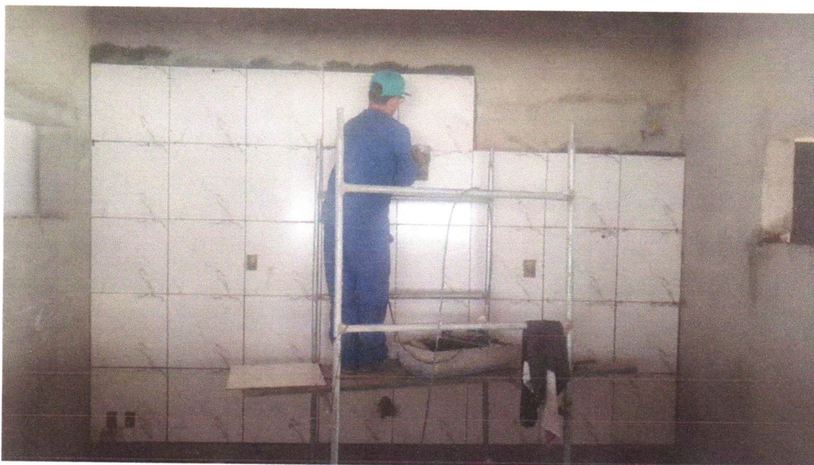
FOTO 20 - REVESTIMENTO CERÂMICO PARA PAREDES INTERNAS COM PLACAS TIPO ESMALTADA EXTRA DE DIMENSÕES 33X45 CM APLICADAS EM AMBIENTES DE ÁREA MAIOR QUE 5 M 2 NA ALTURA INTEIRA DAS PAREDES. AF_06/2014
