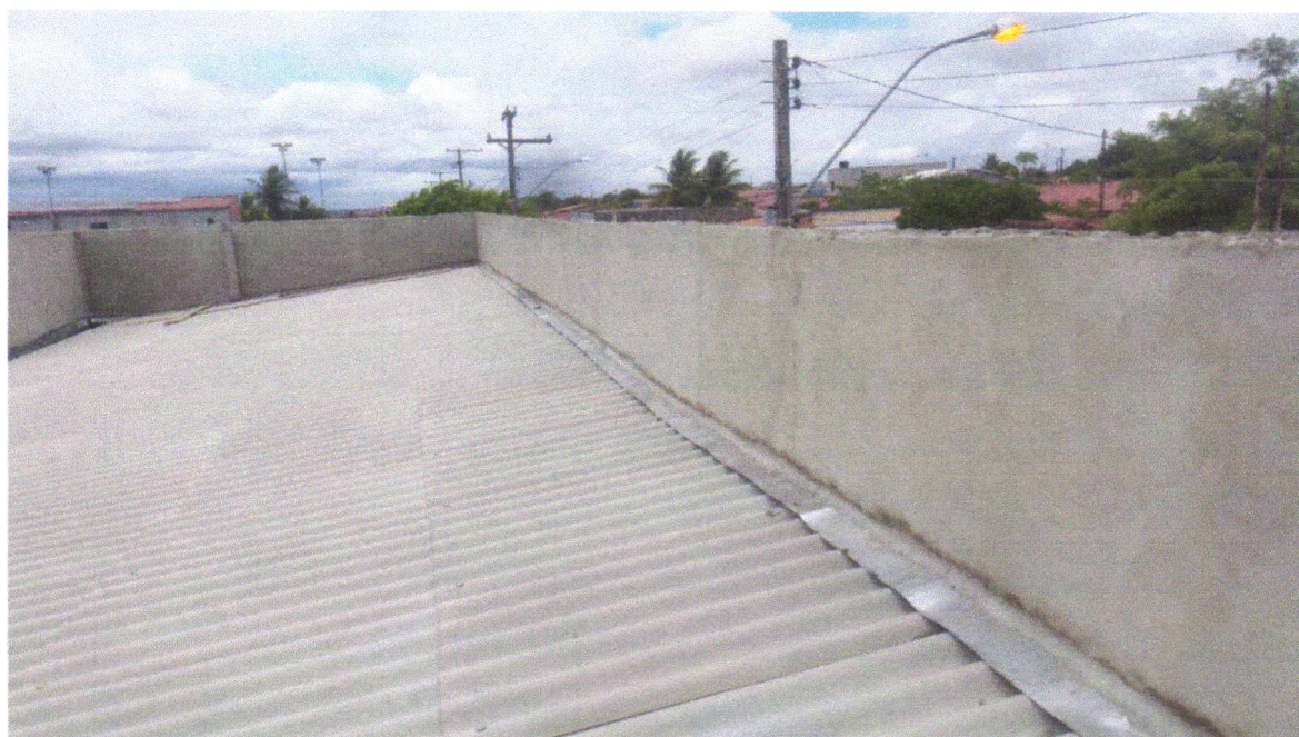
FOTO 28 - Rufo em chapa aço galvanizado nº24 com desenvolvimento 25cm
