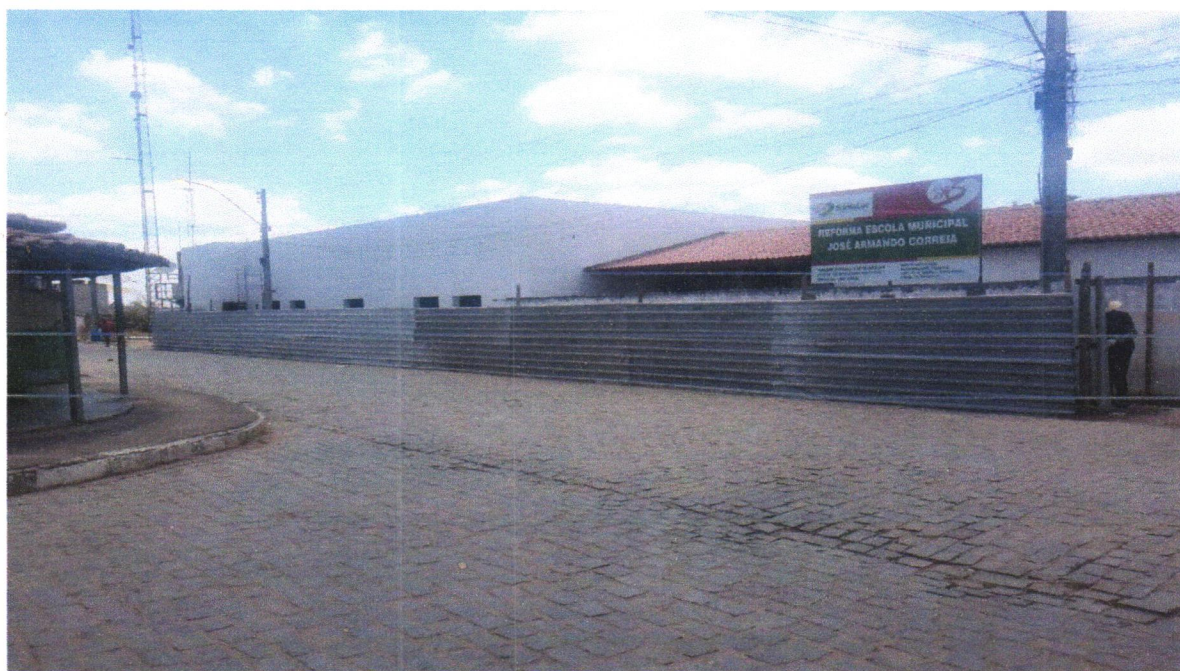
FOTO 02 - TAPUME COM TELHA METÁLICA. AF_05/2018
